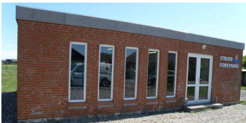
Fousing Vandværk, Kilenvej 6, Fousing, 7600 Struer
